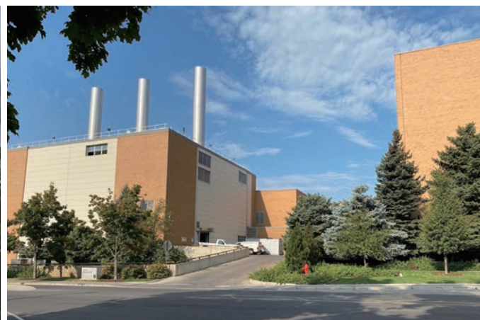
BYU's new Trigeneration Facility 杨百翰大学新冷热电联产能源站
