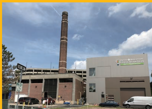
Baystate Medical Center CCHP Plant 贝斯泰医学中心冷热电联产能源站
