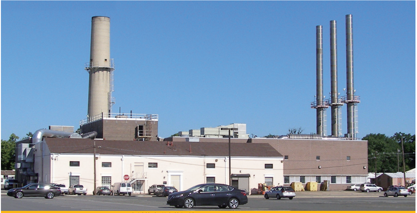
Busch Cogeneration Plant 布希热电联产能源站
