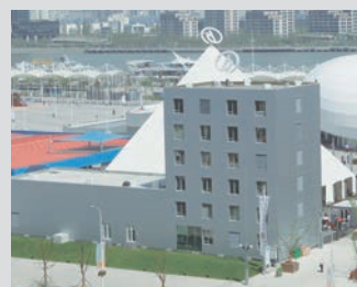
강구조 프리패브 건축물: 1세대 기술 3번동, 위안다관
