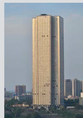
第3世代技術2棟目 57階建てを19日間で建設
