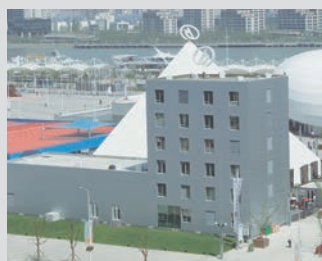
鉄骨プレハブ建築: 第1世代技術 3棟目: 遠大館
