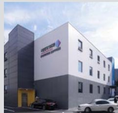
Tecnología de 6.ª generación Construcción prefabricada de acero inoxidable Holon 1.0 Entre marzo y mayo de 2020, se construyeron en Corea del Sur dos unidades de aislamiento hospitalario con presión negativa para hacer frente a la COVID-19. Este edificio fue la cuarta unidad de Holon construida con paneles sándwich de acero inoxidable
